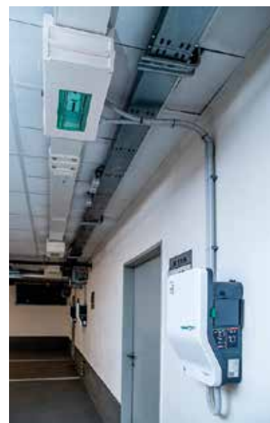
Odbočovací jednotka přípojnicového vedení Canalis k nabíjecí stanici Smart WallBox 22 kV
